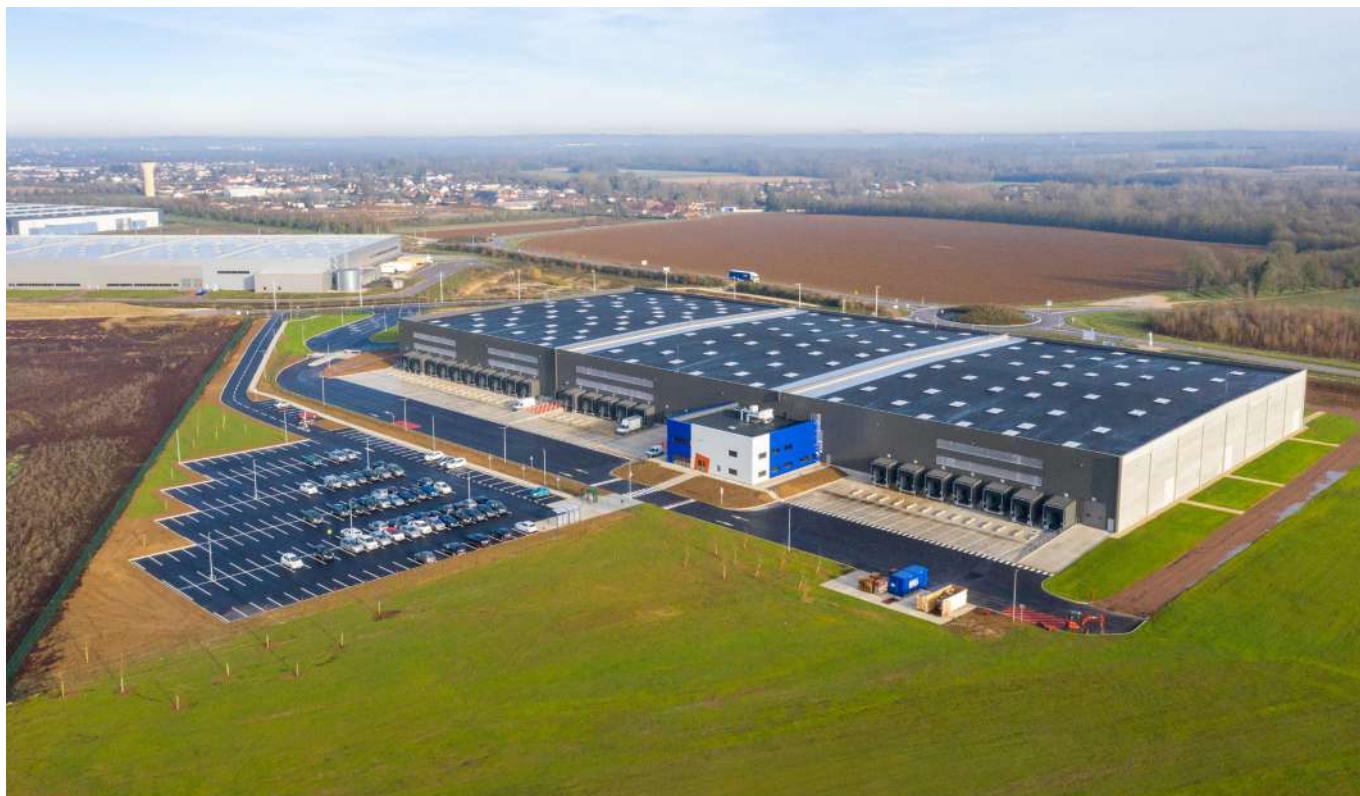
Zac du Parc Logistique de l'Aube - Troyes
